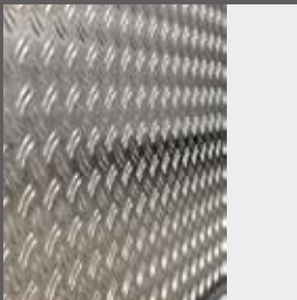
Bodenplatte mit Aluriffelblech belegt
